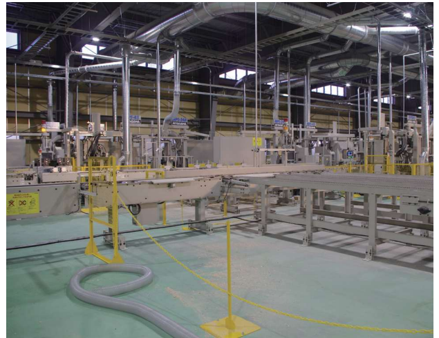
大断面加工機への搬送コンベア
