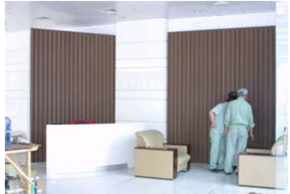
建設中の上海浦東地区の建材センター
