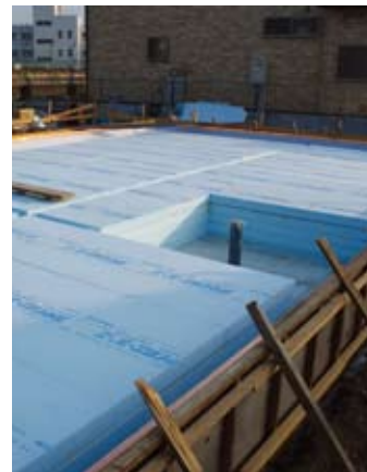
パッシブハウスの逆ベタ基礎（茨城県石岡）
