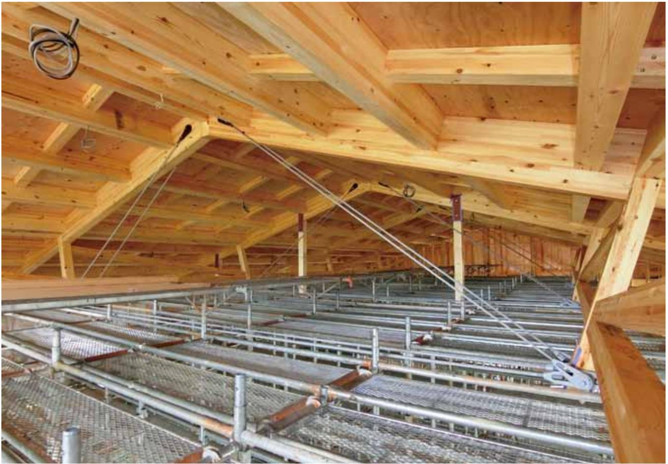
ATAハイブリッドトラスは全部で6フレーム、トラススパン（柱間距離）は14・56 m
