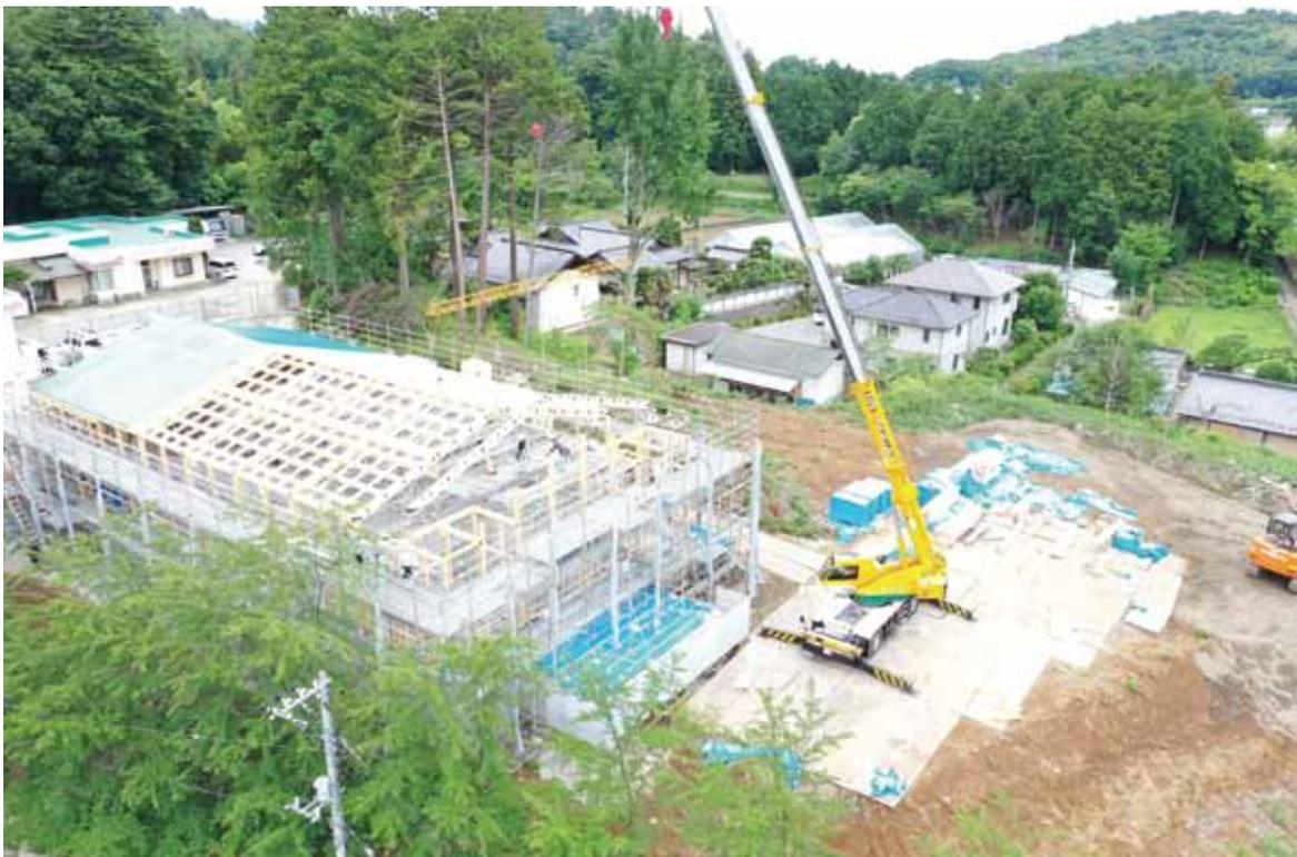
建て方工事の様子 クレーン車でATAハイブリッドトラスを吊り上げる
