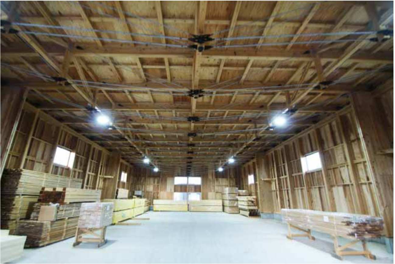
完成した「県産材利用促進センター」 オール県産無垢材スパン約15m、積雪130cmに対応
