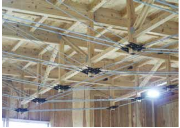
全国初のA-TAハイブリッド構法 全自動プレカット加工ラインによって断面欠損の極めて少ない接合部を実現
