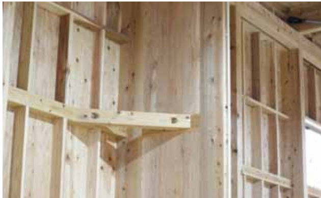
妻面と中間部に耐力壁を設置 火打ち梁も配置
