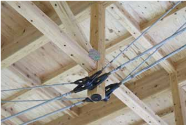
全国初のA-TAハイブリッド構法 全自動プレカット加工ラインによって断面欠損の極めて少ない接合部を実現
