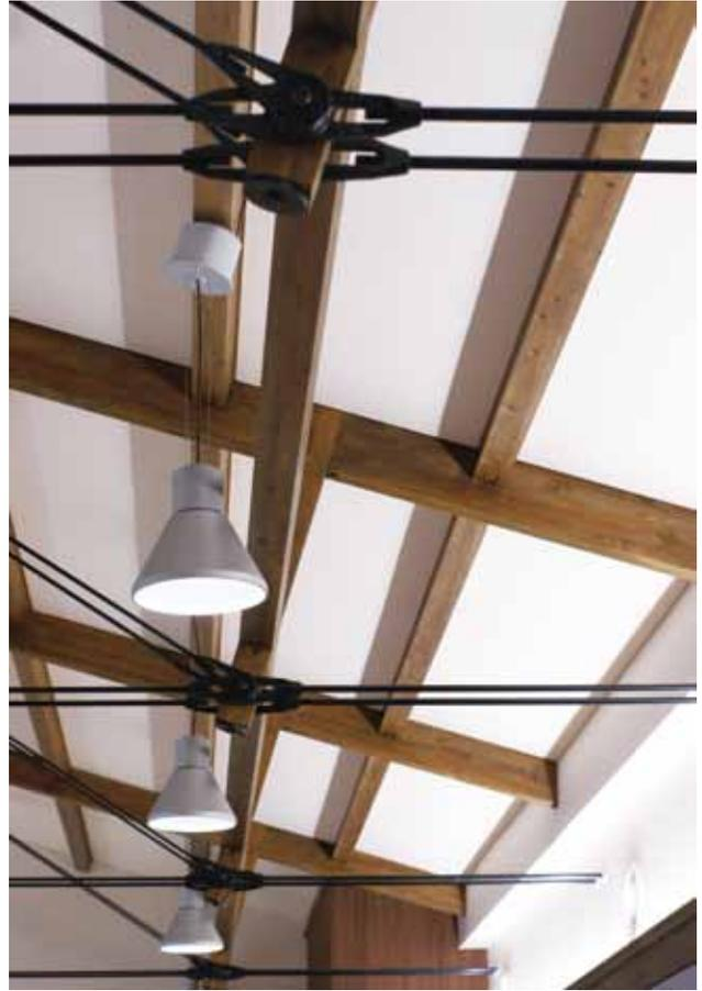
ATAハイブリッドトラス、吊下げ式の照明、患者に配慮して上向きに設置したエアコンで統一感のあるデザインに仕上げた
