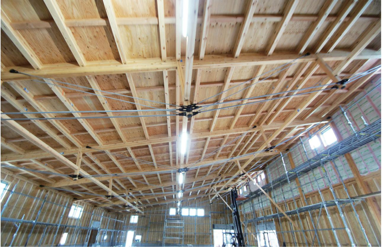
南北 46・4 m、東西 15 m の焼き菓子の製造工場が木造で建設工事中
