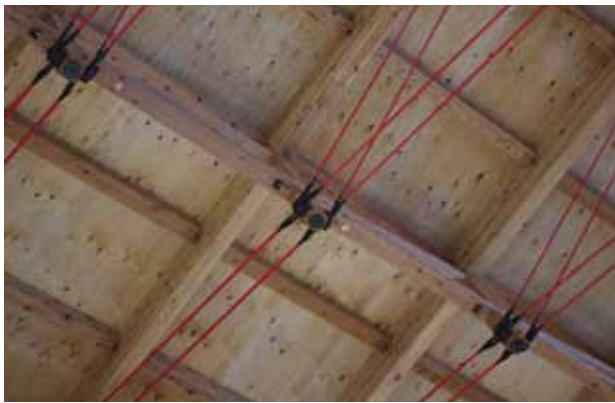
複数の金物が干渉しないよう取り付けられている
