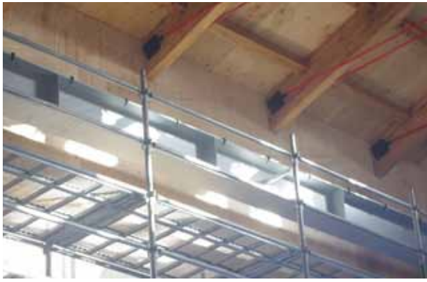
工場内には2基のホイストクレーンを設置するためのランウェイレールが敷設されている
