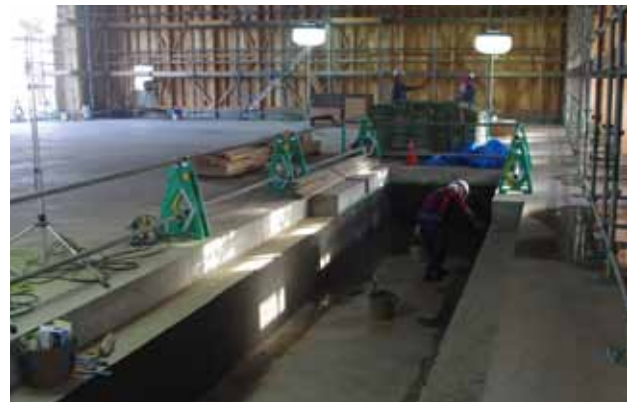
特殊加工機を設置するための床工事
