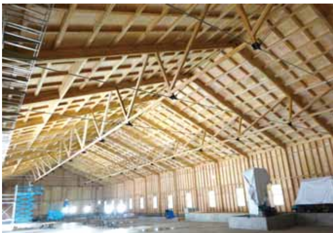
黒田木材商事(株)の大型製材工場（佐賀市）
