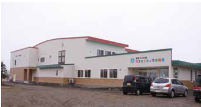
認定こども園第2はくちょう増築部
