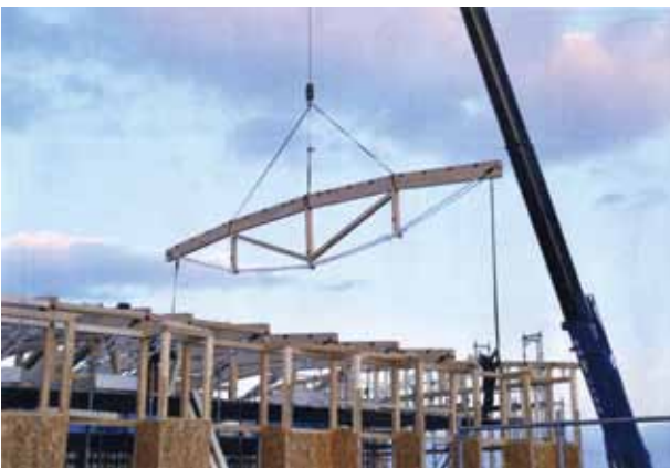
クレーンを使ったATAハイブリッドトラスの建て方工事
