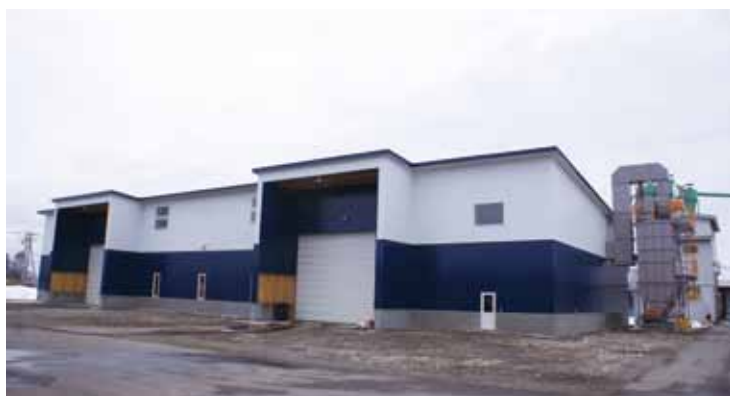
マルジュウランバー(株) 在来工法プレカット工場（帯広市川西町）
