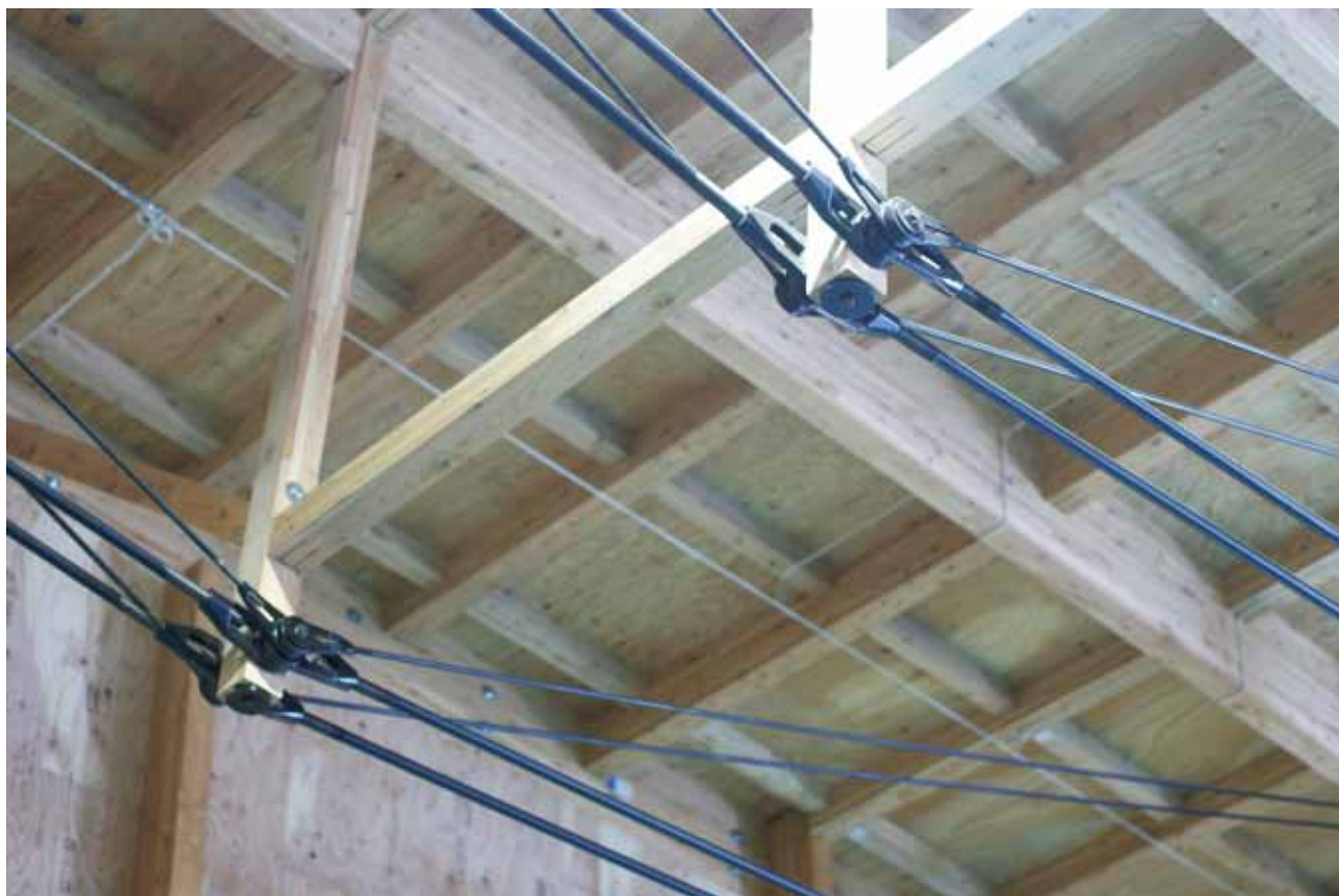
スパン 20 m の A T A ハイブリッドトラス（張弦梁タイプ）を 26 フレーム使用
