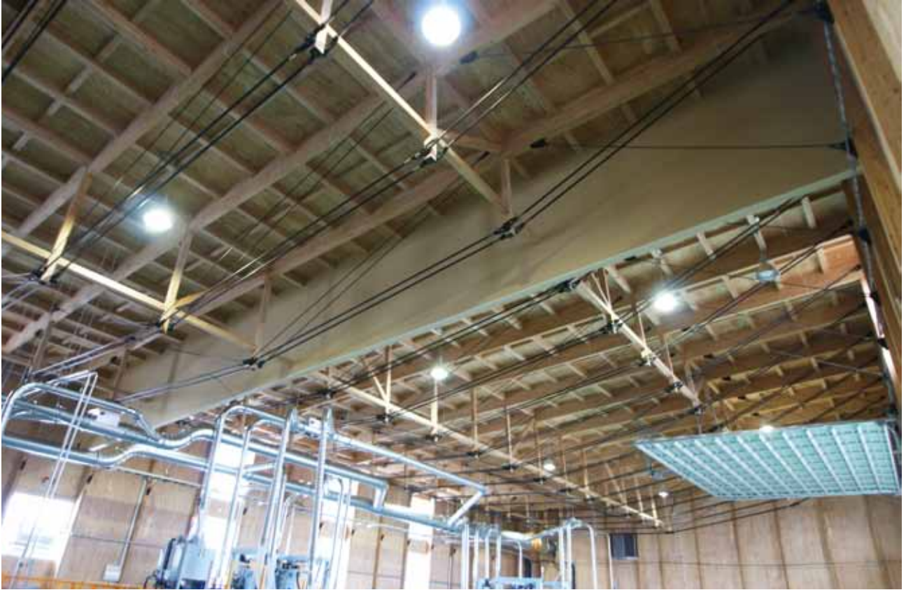
500㎡で単位で石膏ボードによる防煙壁を設けている
