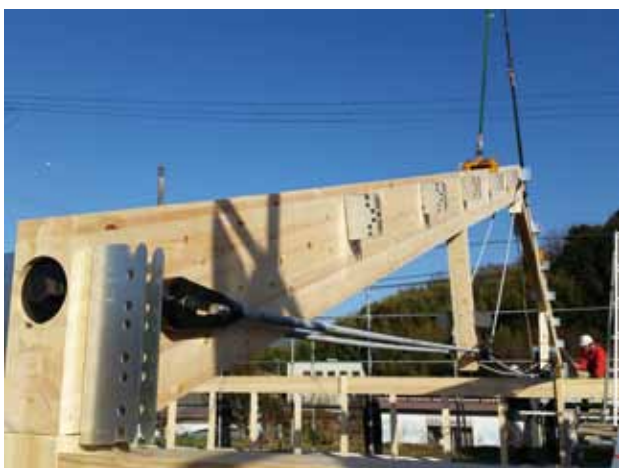
クレーンで吊り上げられる ATA ハイブリッドトラス
