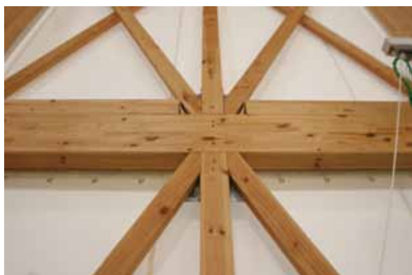
外壁はテント膜素材、躯体は金物工法
