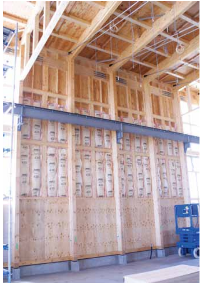
9mの壁面に充填されるグラスウール断熱材
