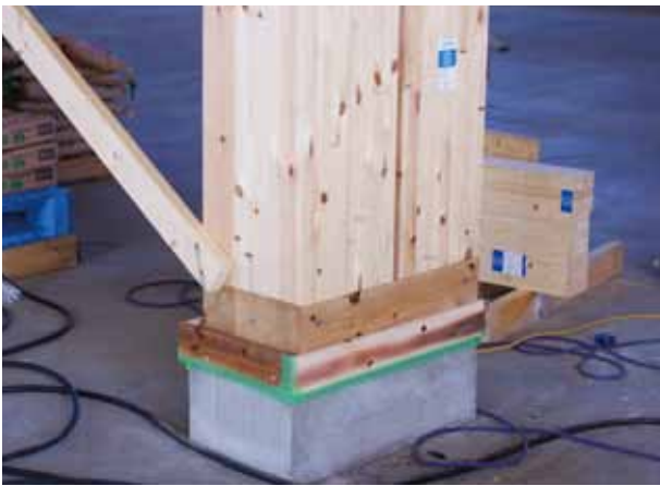
105mm×300mm×7000mmのRW集成材を固定している
