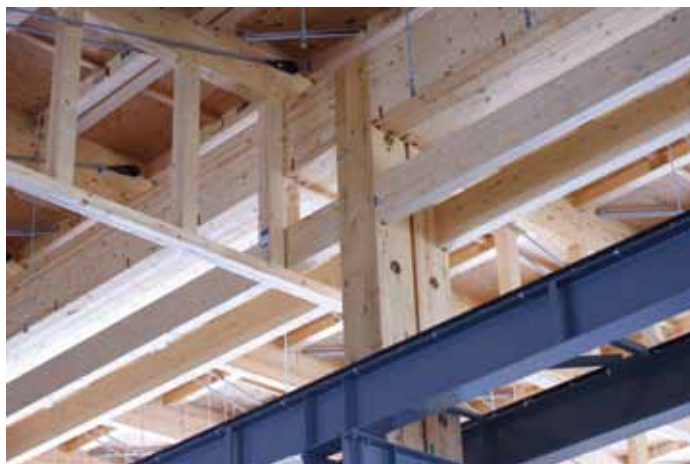
水平屋根のSAタイプ 屋根形状、勾配、スパン 別に全14タイプがある
