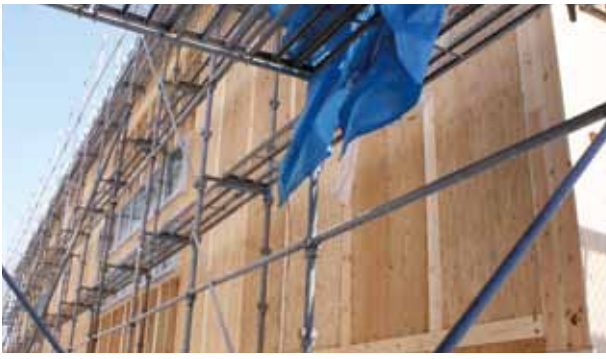
真壁パネルを使って短工期で施工した
