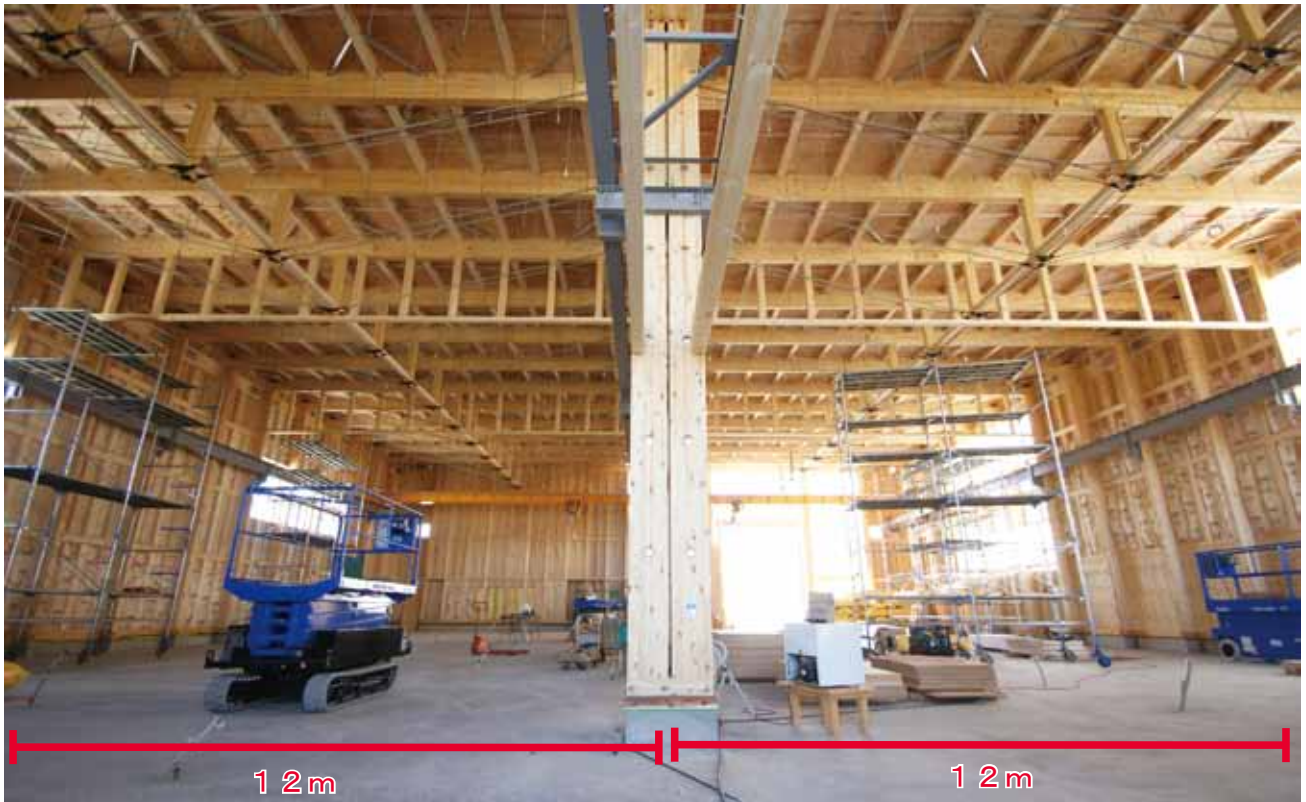
12 mのSAトラスを2つ組み合わせて24 mとしている。中央の柱は工場のクレーンとトラスの連結部を支える
