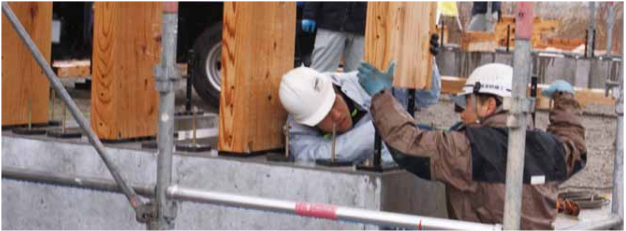
最長9mの柱を柱脚金物のほぞパイプに落とし込んでいく
