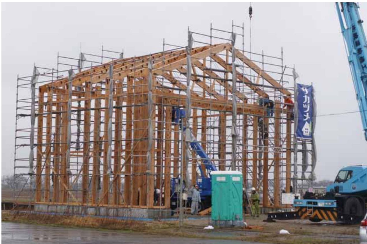
夕方4時半に、合計6フレームのATAハイブリッドトラスの取付けが完了した
