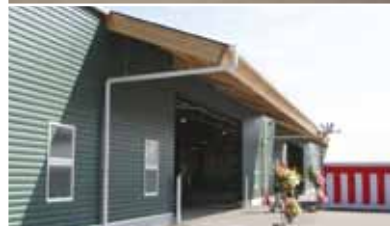
富士大和製材工場
