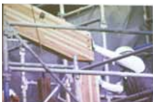
ATAハイブリッドトラスの施工
