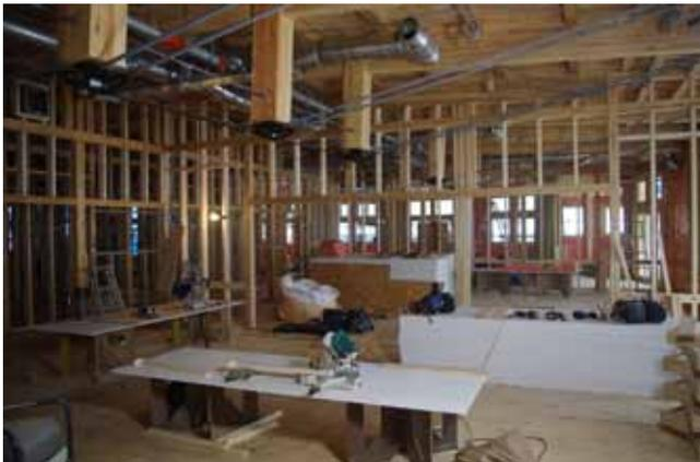
保育室の施工の様子 10.9mのトラスが見える
