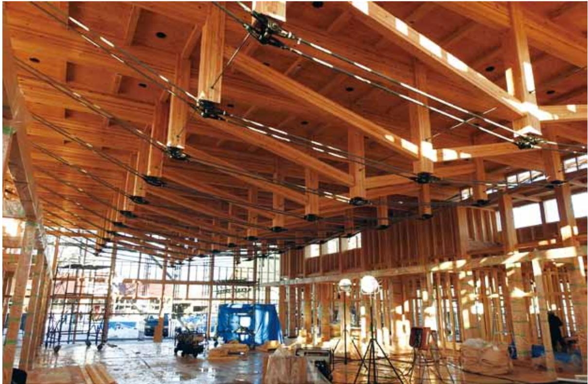
鉄骨造と同等のコストで大スパンの架構を実現するATAハイブリッド構法
