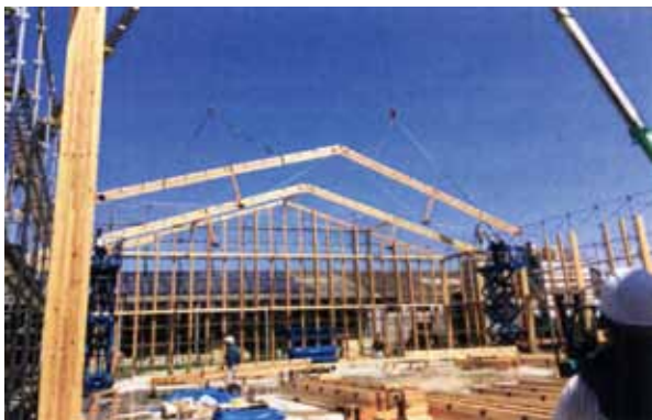
大型クレーン2台で吊り上げる
