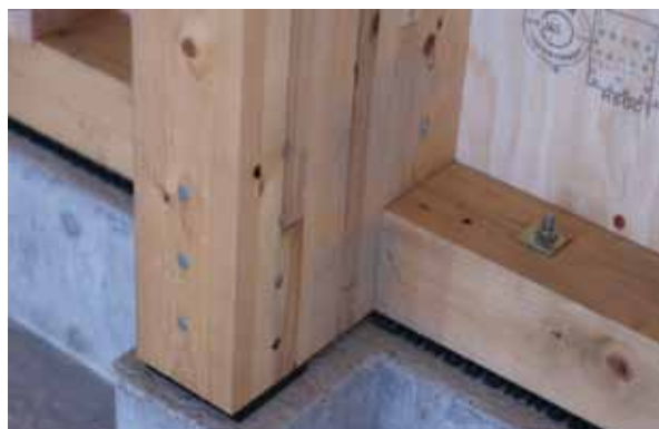
柱脚金物に柱を入れ、ボルトに間柱を入れた状態
