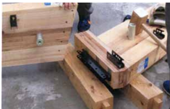
A T Aハイブリッドトラスを現場で地組みする
