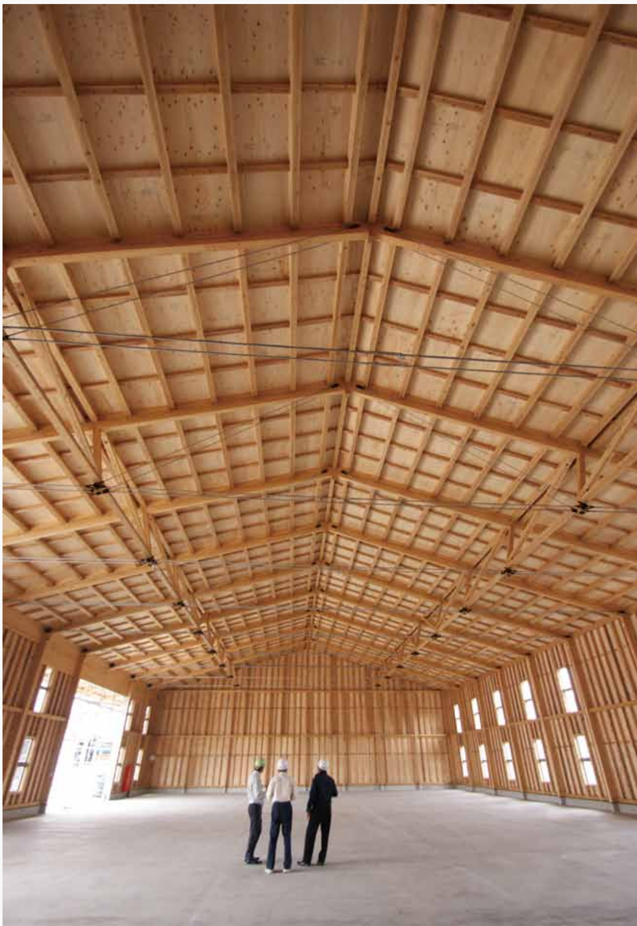
東西 21m840mm 南北 40m400mmの木造大空間 ATA ハイブリッドトラス (TM タイプ) が10 フレーム入っている
