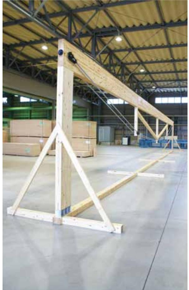
講演後に一行は、会場である大三商の東金プレカット工場内に移動、工場内に展示された22mの実大トラスを視察。さらに6mの山型トラスの組立実演をおこなった。6mの山形トラスは、11mのトラスで用いられる断面寸法の梁を用いて見学者向けに組み立てたモックアップである。組立ては解説を行いながら30分ほどで組み立てられた。22mのトラス、6トラスも一般流通材を用いており、6mのオウシュウアカマツ105mm×450mmを4本、タイロッドで
