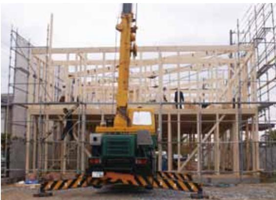
中大規模木造新工法「ATAハイブリッド構法」の採用が進んでいる。11月21日に愛知県大府市で行われたハウストウ大府東浦店・リフォームギャラリー大府新店舗の建設工事（施工：㈱エネチャ・ホームエコ、設計：関建設事務所、プレカット：㈱シンホリ デザイン・鳥居デザイン事務所）における建て方工事では、片流れ屋根に3フレームのATAハイブリッドトラスが用いられた。建物は道路沿いに面した総2階建の100坪のショールーム兼事務所。ATAハイブリッド構法による片流れ根用の張弦梁を3フレーム用いて11m×11mの大空間を実現して
