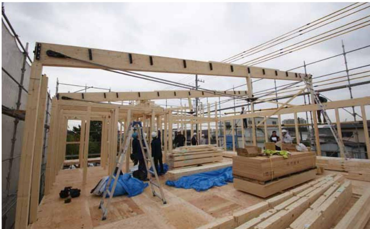
ATAハイブリッド構法による片流屋根用の張弦梁を3フレーム用いて11 m×11 mの大空間を実現
