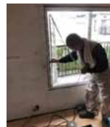
④レーザーで水平、垂直を確認
