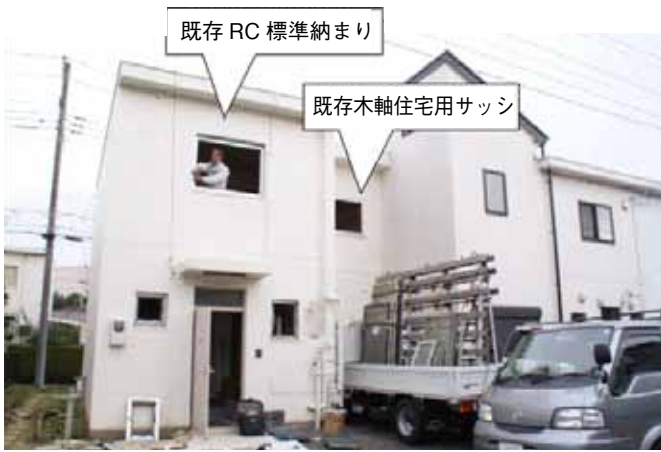
築47年長屋建RC住宅
