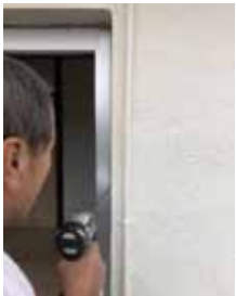
⑤改装用水切りを現場に合わせて加工
