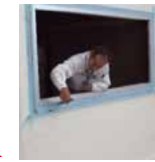
⑩外部変成シリコン打設
