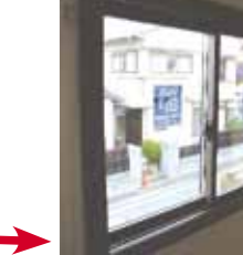
⑫施工完了
