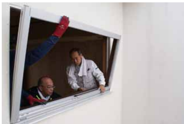
既存枠の歪みを調整してサッシ枠を取り付ける
