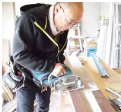
窓枠材の加工では丸鋸も使う
