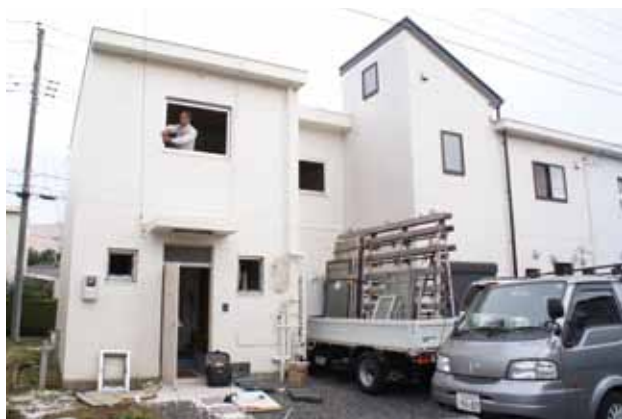
集合住宅（RC造）アルミ樹脂サッシ設置工事
