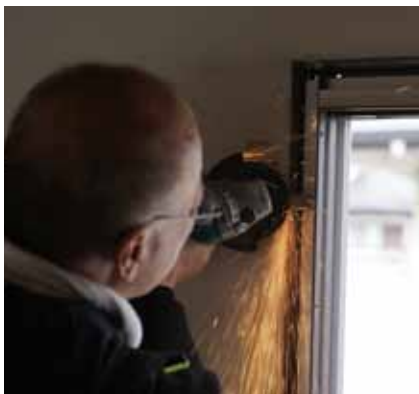
接合金物の干渉部をディスクグラインダーで削る
