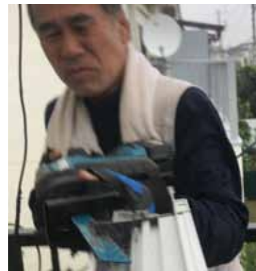
枠の上下左右干渉部はレシプロソーでカット
