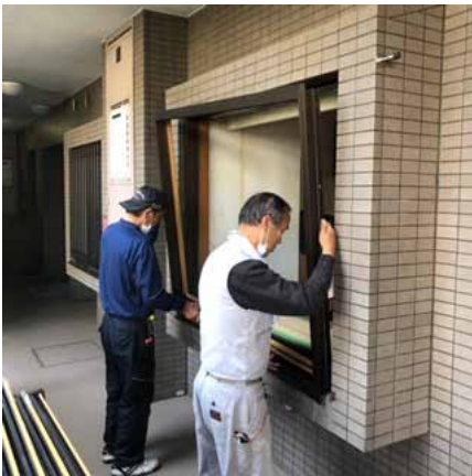
新規枠を既存枠にはめこむ
