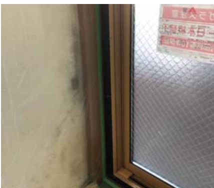
室内側の額縁を施工して完了
